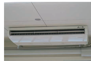
エアコンを更新(本社)
